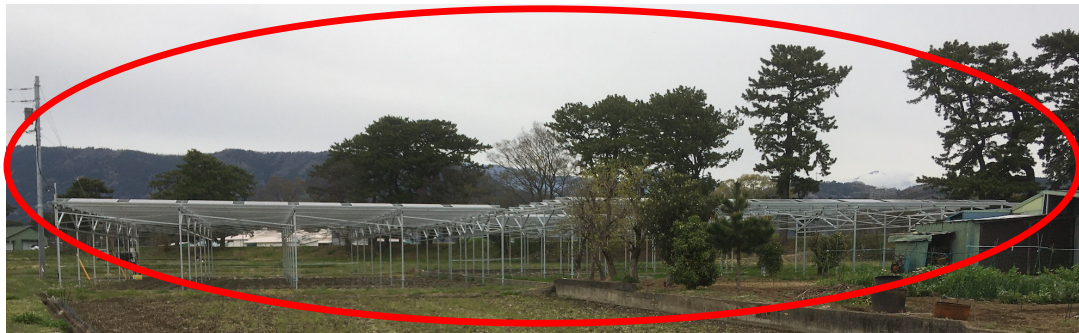
かなごてファーム 金次郎の里発電所
